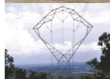
Torre de Suspensión 500 kV en Brasil Torre de Suspensão de LT-500 kV no Brasil
