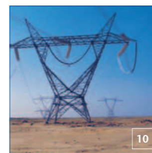
01 380 kV Abspannmast in Österreich
